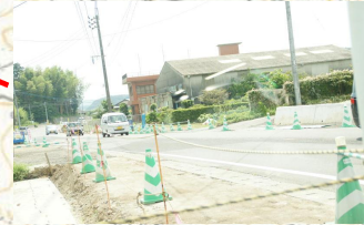
3 宮脇 交通量多し 歩道はH30に完成予定
