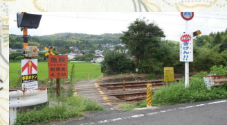
16 麓東 小諏訪踏切 遮断機無し
